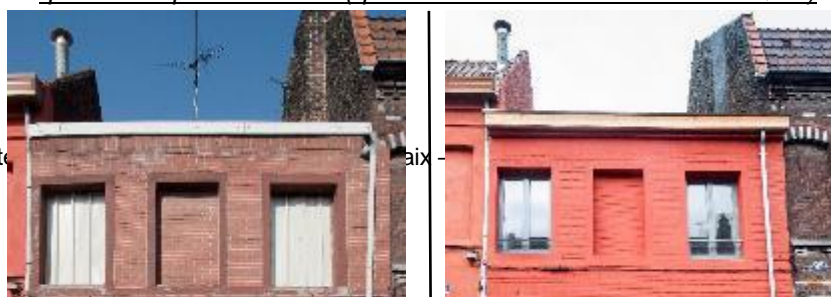
Avant/après travaux, réhabilitation en ORI menée sous maîtrise d'ouvrage de La fabrique des quartiers à partir de 2017 (quartier du Pile – Roubaix – PMRQAD)
